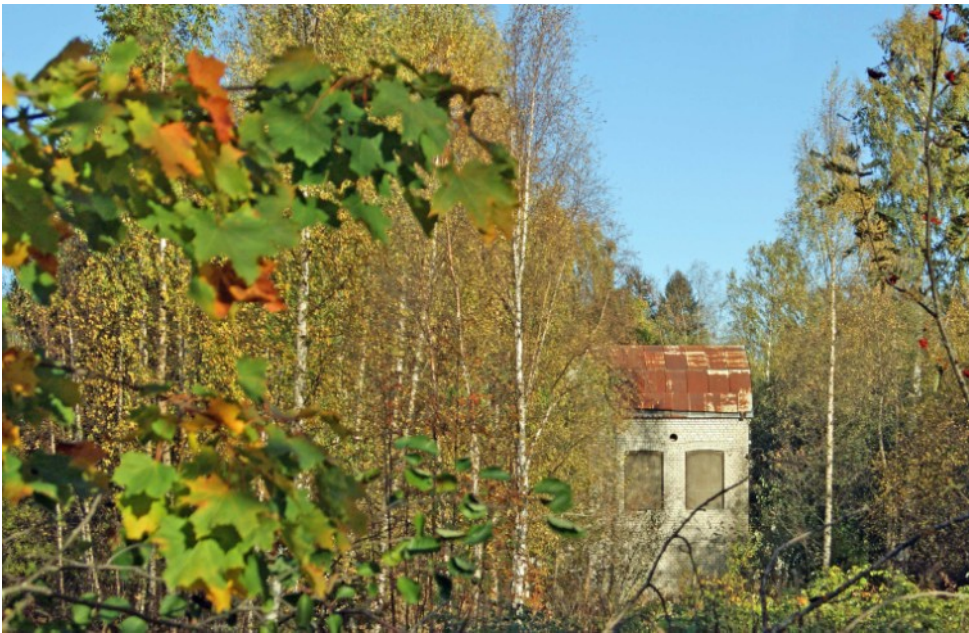
Ställverket, en av få kvarvarande industribyggnader vid Kramforsviken.
