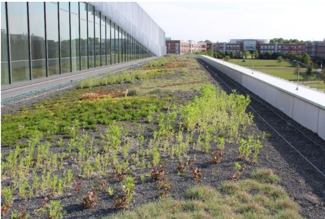
Figur 10. Exempel på grönt tak (Bild av Laila Søberg, 2014).
