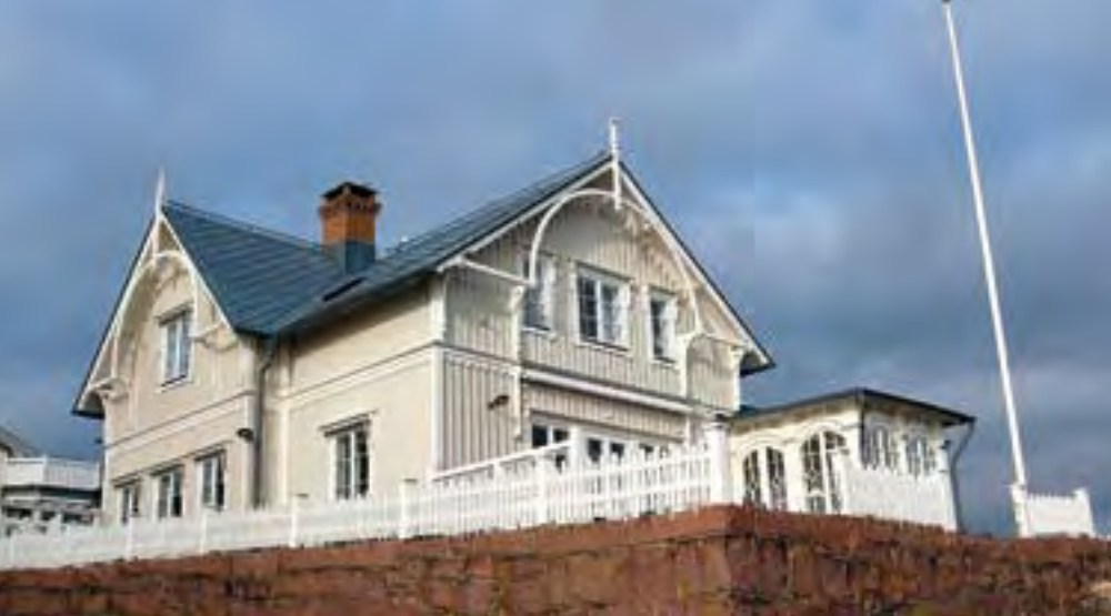
Hus med vacker fasad som bör bevaras och därför inte tilläggsisolerar utifrån.
