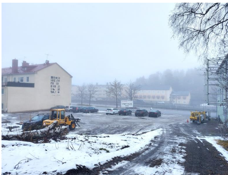
Figur 2: Bild från platsbesök i november 2023. På bilden syns fastigheten Mercurius 11.
