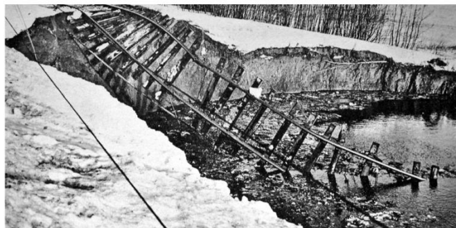
Här syns hur järnvägsrälsen har vridit sig och hänger över raset.
